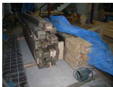
写真1 材料の補修状況
