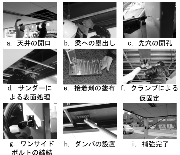
写真2 各手順の施工状況
