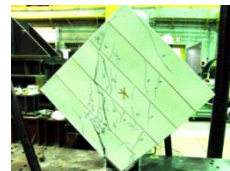
図 8 破壊後の試験体 (ALC50)
