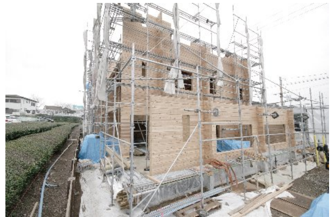
写真 2 建設途中外観
