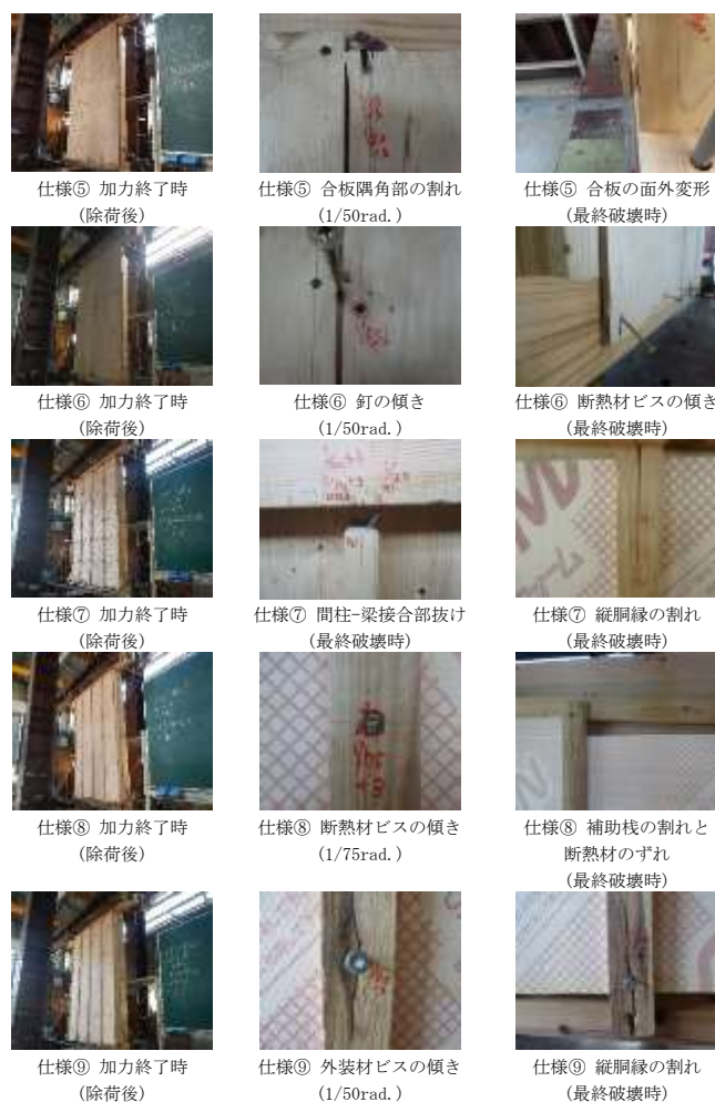
図2 損傷個所の一例
