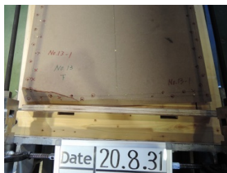
写真.1 面材の座屈(No.13)
